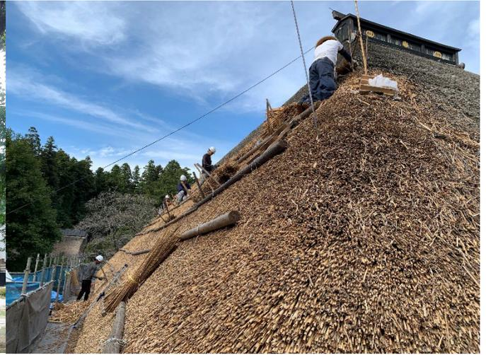
◇医王寺金堂は、宝永3年（1706）に上棟され、棟梁は干本（せんぼ・現芳賀郡市貝町田野辺地区）の宮大工、長野万右衛門の二代目がつとめた、茅葺き屋根・寄棟造の建造物です。平成19年から平成24年までの五年間をかけて、茅葺き屋根の全面的な葺替工事や新たな彩色を行い、往時の姿がよみがえりました。その後、約10年が経過し屋根の腐食が進んだため、令和4年より栃木県・鹿沼市・檀信徒各位のご協力により、屋根の差し茅（さしがや・腐食した箇所）の取替修理）工事を実施しております。現場見学会では、保存修理を担当している(有)熊谷産業（宮城県石巻市北上町）が工事の概要を説明致します。
